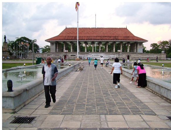
(d) Memorial Hall, showing open sides
