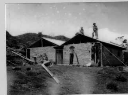
Juan construyendo la casa Paterna
